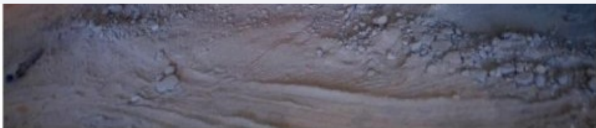
Korytarz – źle wykonana warstwa cementowo-klejowa na podłodze. Brak związania z deskami oraz znaczna kruchość elementu.
