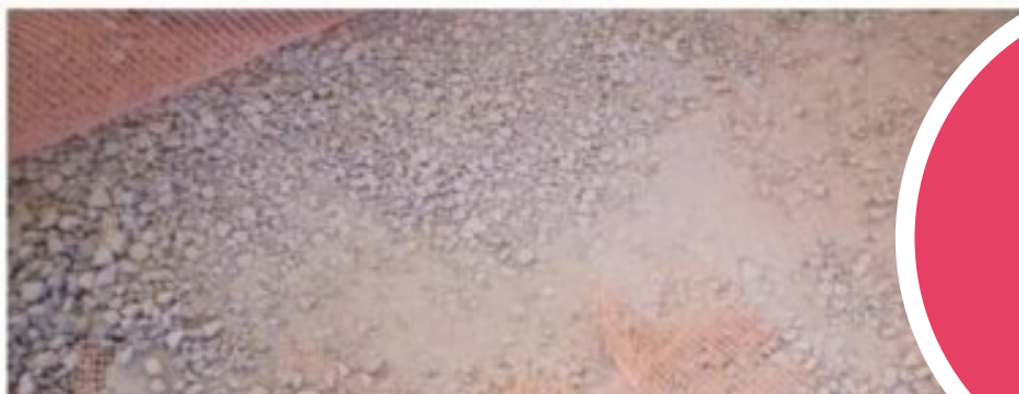
Korytarz – źle wykonana warstwa cementowo-klejowa na podłodze. Brak związania z deskami oraz znaczna kruchość elementu.
